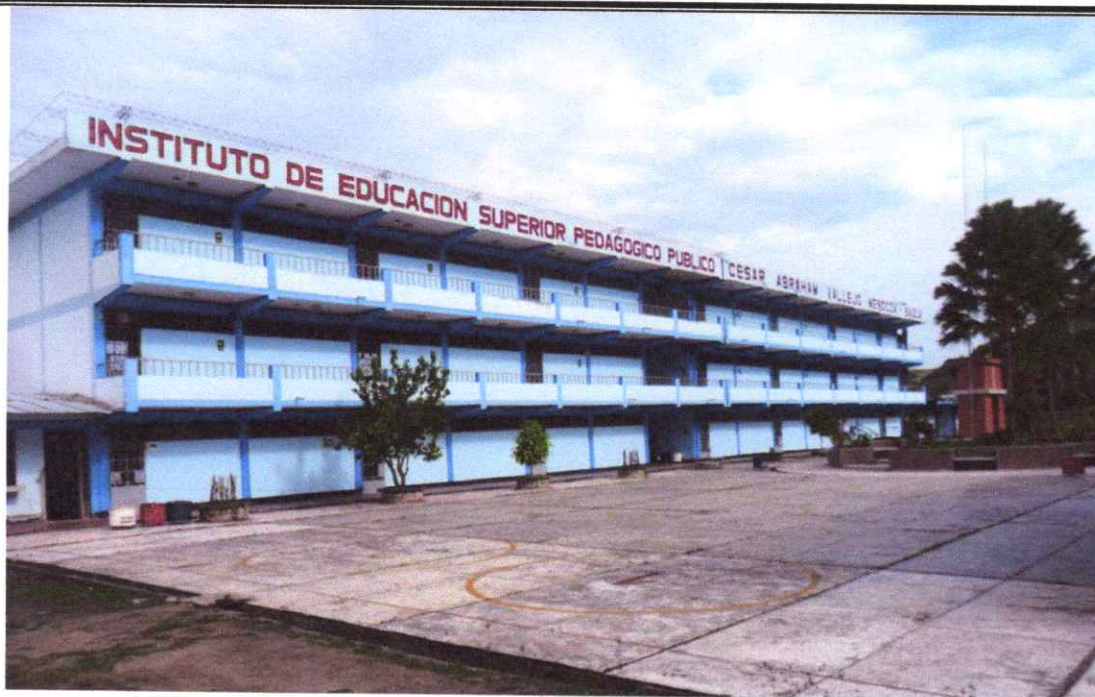
Foto 01: Se muestra el pabellón de aulas y patio existente, en buenas condiciones de funcionalidad y estética.
