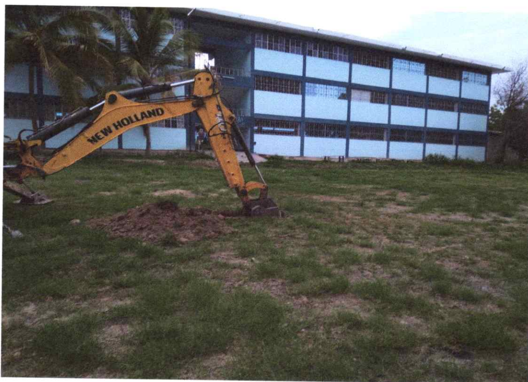
Foto 04: Se muestra la parte posterior del pabellón de aulas existente, en buenas condiciones de funcionalidad y estética.
